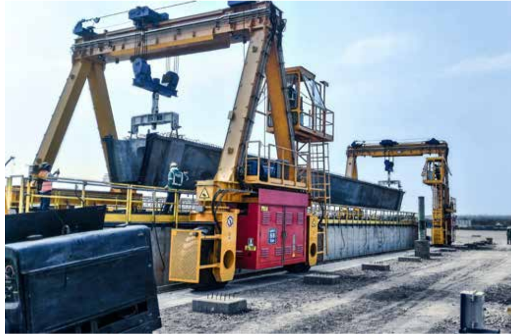
Für die längste Straßenbrücke Kolumbiens wurden insgesamt 387 solcher V-Träger produziert.
