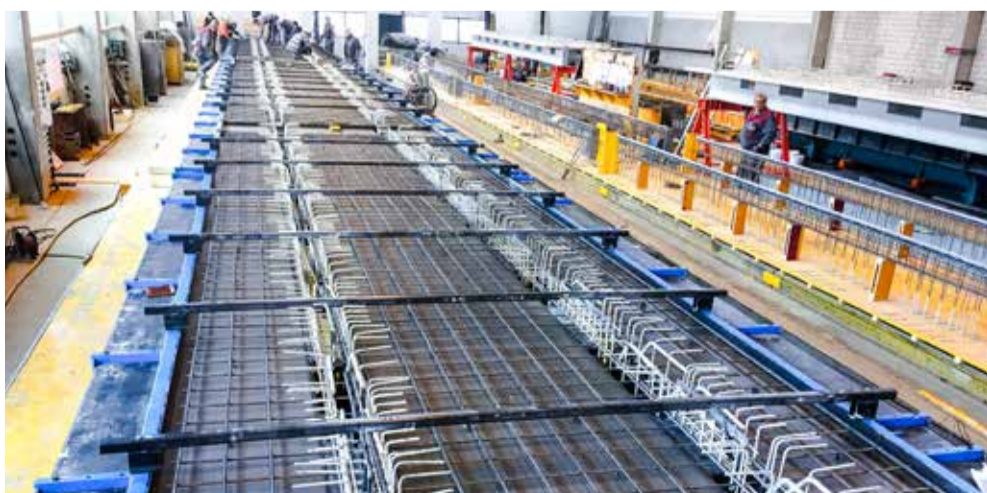
Auf den flexiblen Grundrahmen können zwei verschiedene Schalungen montiert werden.
