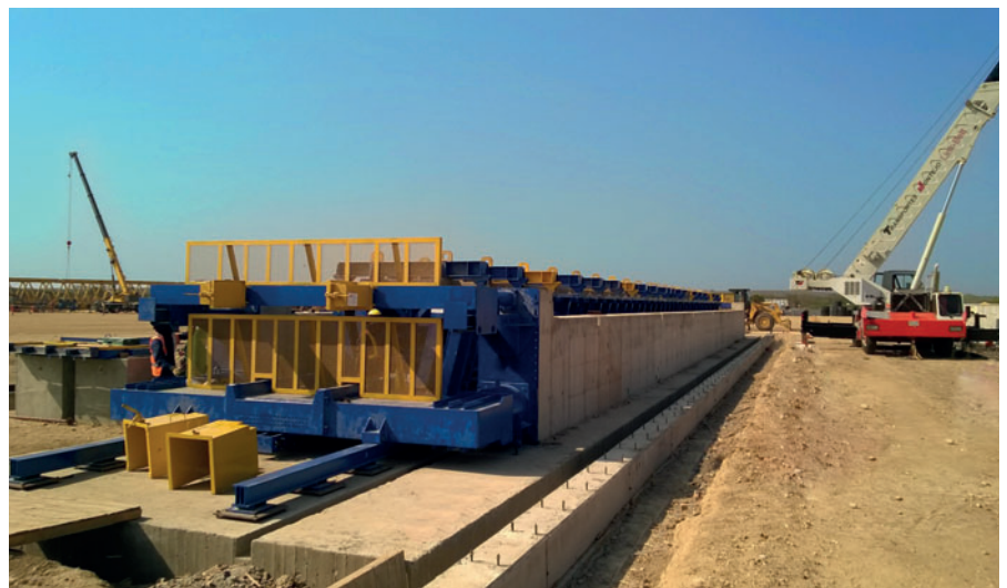
Die 40-m-Schalung wurde unweit der Baustelle installiert. Sie ist ortsunabhängig einsetzbar, da sie über ein System zur Aufnahme der Vorspannkräfte verfügt.
