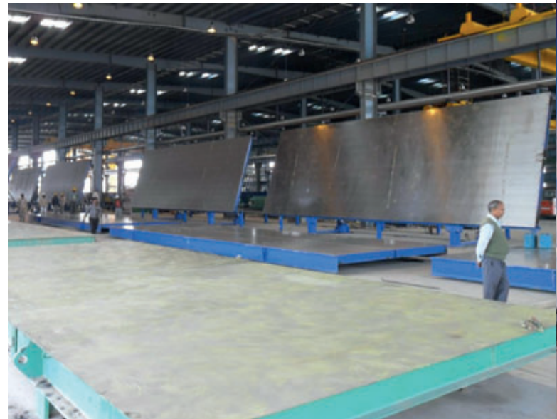
tecnocom lieferte insgesamt 36 TTE-Kipptische in das Werk von Amrapali Precast im Südosten Neu-Delhis.
